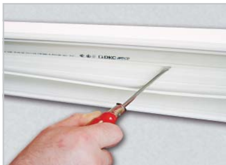
Для снятия разделителя с короба воспользуйтесь плоской отверткой, вставив её в специальный желоб
