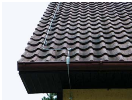
Токоотвод, смонтированный на черепичной кровле
