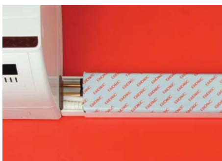
Закройте смонтированную трассу крышкой
