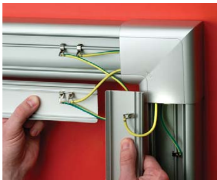
Количество монтируемых проводов заземления в плоском угле
