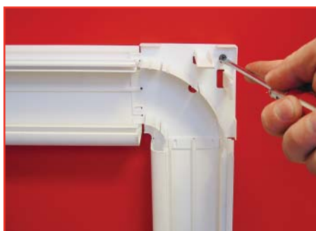
4. Установить 2-ой короб Вставьте в базу угла вторую часть кабель-канала. Закрепите их на стене.
