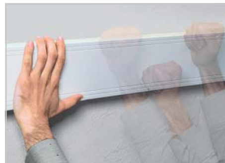
Несколько повторяющихся ударов вдоль короба для закрытия крышки
