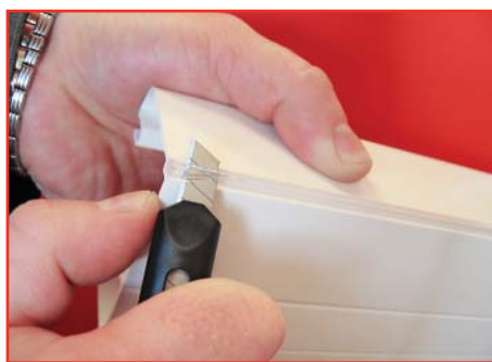
1. Срезать уплотнитель Для лучшего прилегания элементов рекомендуется отрезать часть резинового уплотнителя, заходящего под аксессуар.
