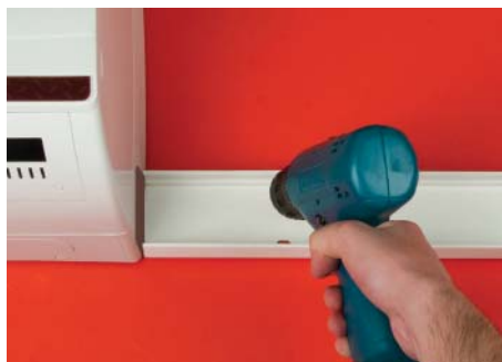
Закрепите основание короба на стене
