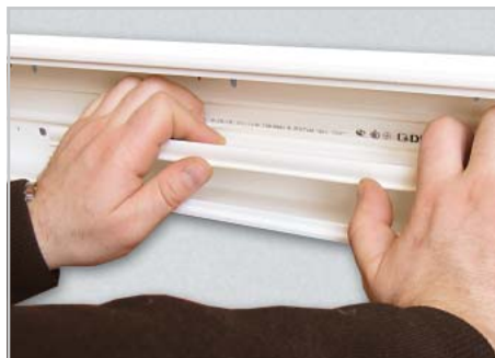
Разделитель защелкиванием устанавливается на направляющие дна короба
