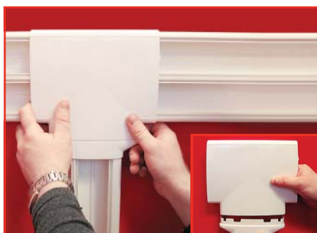
5. Установить переходник При отводе от прямой трассы большого сечения короба меньшего сечения - необходимо вставить под лицевую накладку тройника соответствующий переходник (140-110, 140-90 или 110-90).
