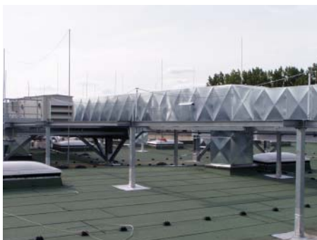
Система отдельностоящих мачт, защищающая воздухопроводы системы кондиционирования.
