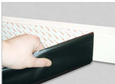
По окончании всех работ снять защитную пленку
