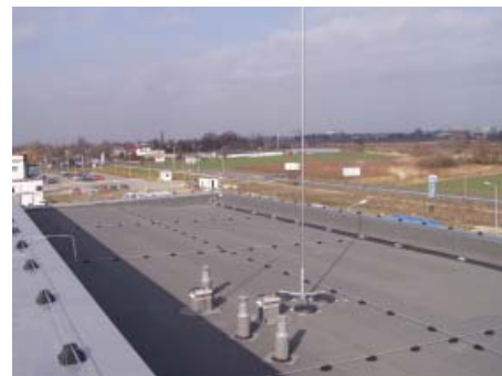
Совместное использование молниеприемной мачты и сетки.
