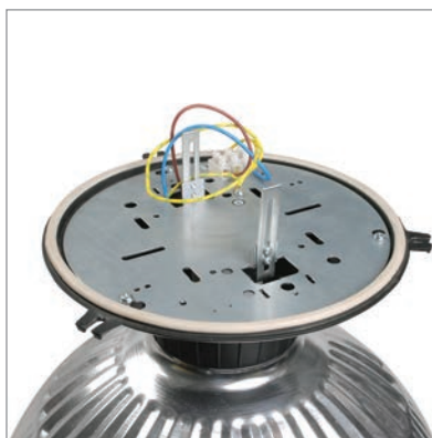
Шаг 1. Демонтаж балласта светильника
