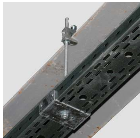
Подвес на шпильку и трубочину к швеллеру
