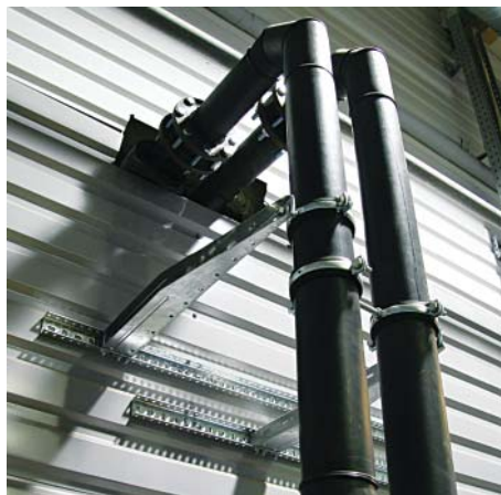
Подвес коммуникаций с помощью консолей
