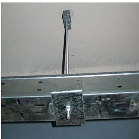
Монтаж на одну шпильку
