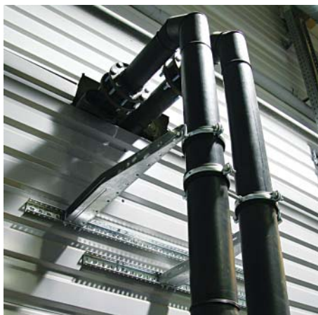
Подвес коммуникаций с помощью консолей
