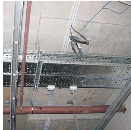
Многоярусный монтаж с использованием профиля и шпилек
