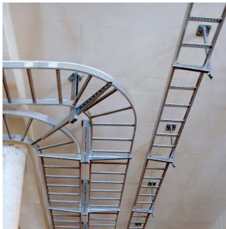
Двухсторонний параллельный подвес трассы лестничных лотков
