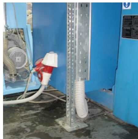
Использование крепления SSM как напольной опоры
