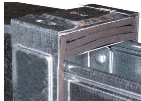
Монтаж резинопластиковых уплотнителей в случаях перехода по высоте лотка
