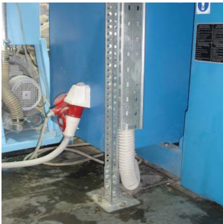
Использование крепления SSM как напольной стойки
