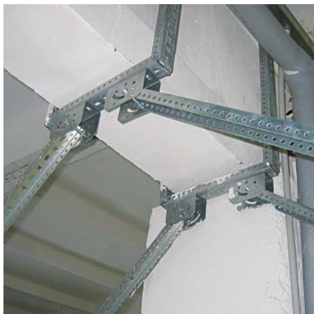
Монтаж узла подвеса к потолку при прокладке трассы с пролетом в 4-6 м
