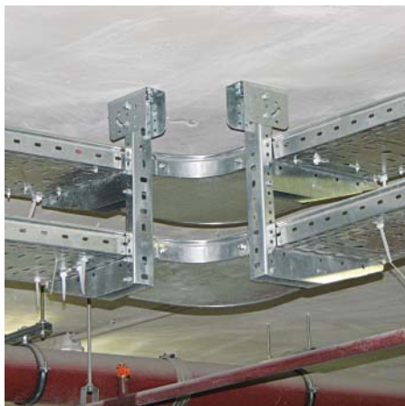
Многоуровневая прокладка кабельной трассы
