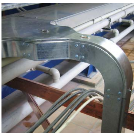
Ответвление лотка с использованием перехода по ширине
