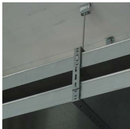
Многоуровневый подвес с использованием скоб STP/STS
