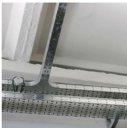
Установка коробки на боковину лотка
