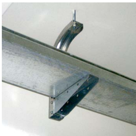
Подвес листового лотка на консоль CS, закрепленной на шпильке к потолку
