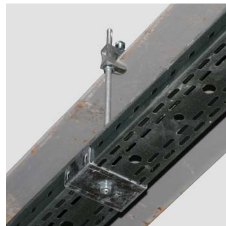
Подвес на шпильку и струбцину к швеллеру
