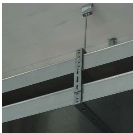
Многоуровневый подвес с использованием скоб STP/STS
