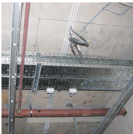
Многоярусный монтаж с использованием профиля и шпилек
