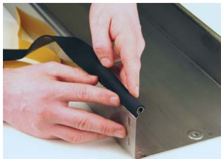
Монтаж ленты толщиной 2 мм на кромку лотка
