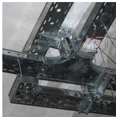
Смонтированная двухуровневая развязка кабельных лотков
