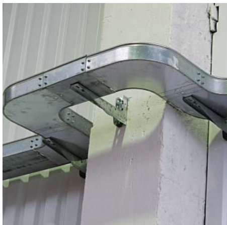
Использование 4-х углов СРО для обхода колонны при прокладке кабельной трассы по стене
