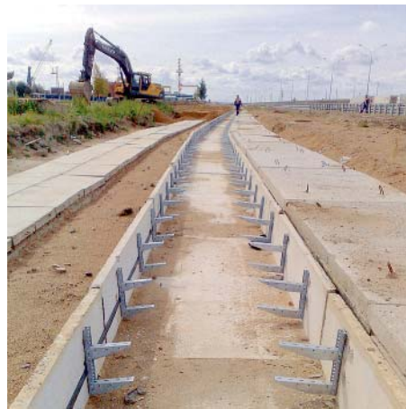
Прокладка кабелей в туннеле
